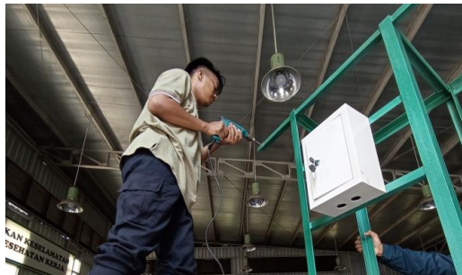
Gambar 5. Proses Pemasangan Komponen pada Alat
