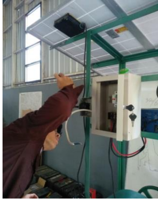
Gambar 10. Proses Perakitan Kelistrikan Tenaga Surya
