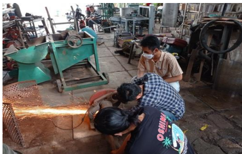
Gambar 6. Proses Fabrikasi Struktur Rangka
